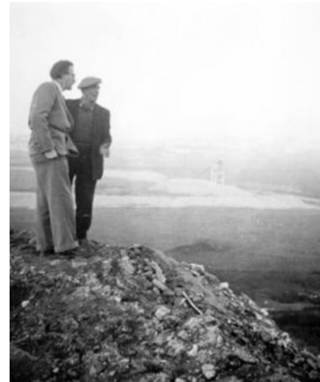
Piero Bottoni e Fernad Lèger sulla montagnetta in costruzione
