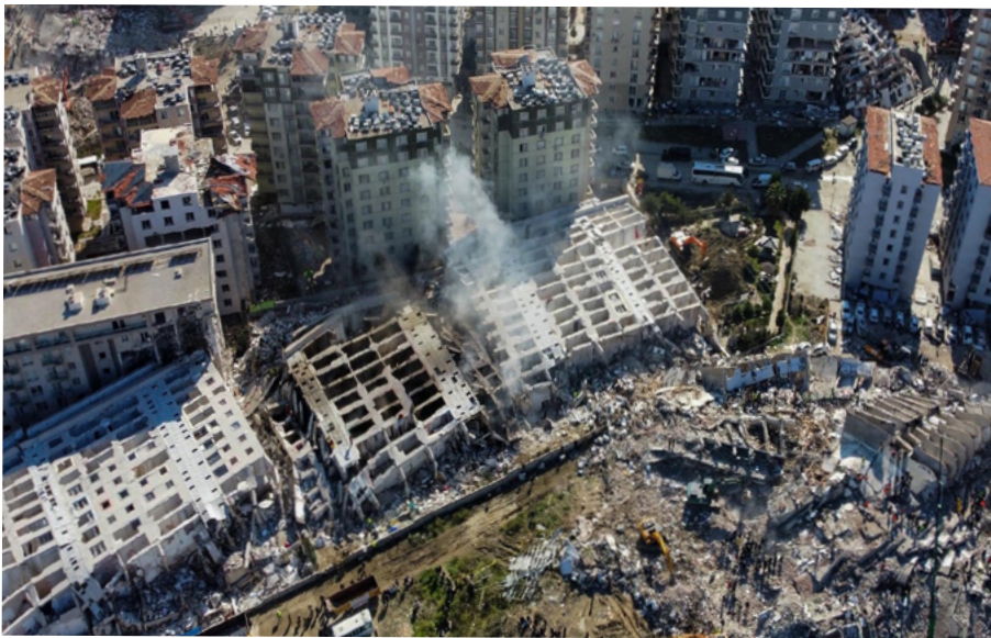
Collasso di un complesso residenziale a Ekinci, Turchia
